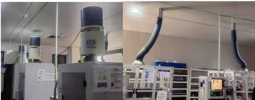
图 3-1 废气收集处理装置图
