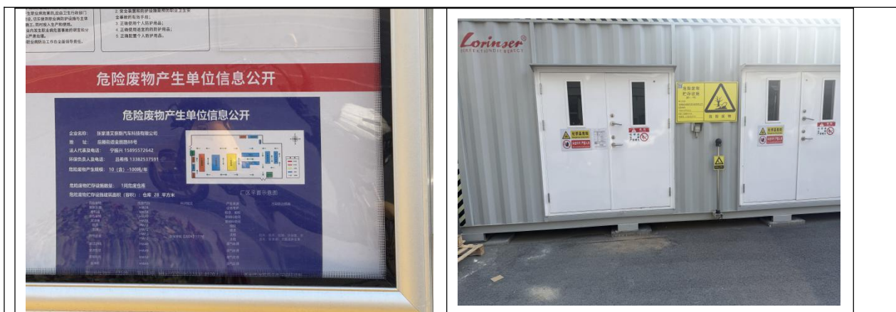
图 3-4 危废仓库建设现状
