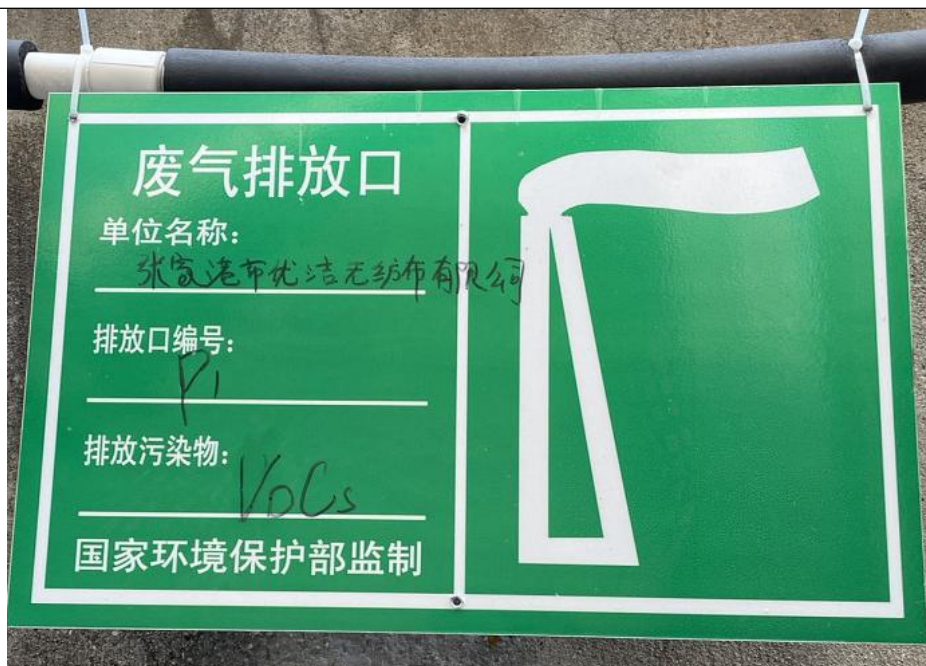
图 10-3 废气排放口标识牌
