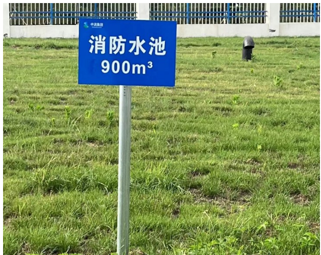
图 3.5-2 地埋式消防水池标识牌
