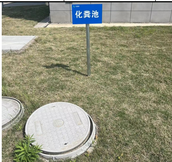
图 3.1-2 化粪池现状照片
