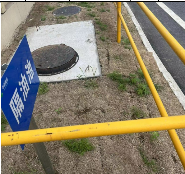
图 3.1-1 隔油池现状照片
