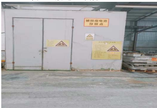
图 4-6 破损废电池存放间
