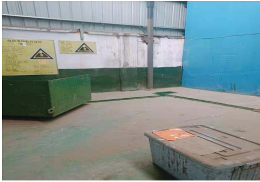
图 4-10 其他危废暂存区 (2)
