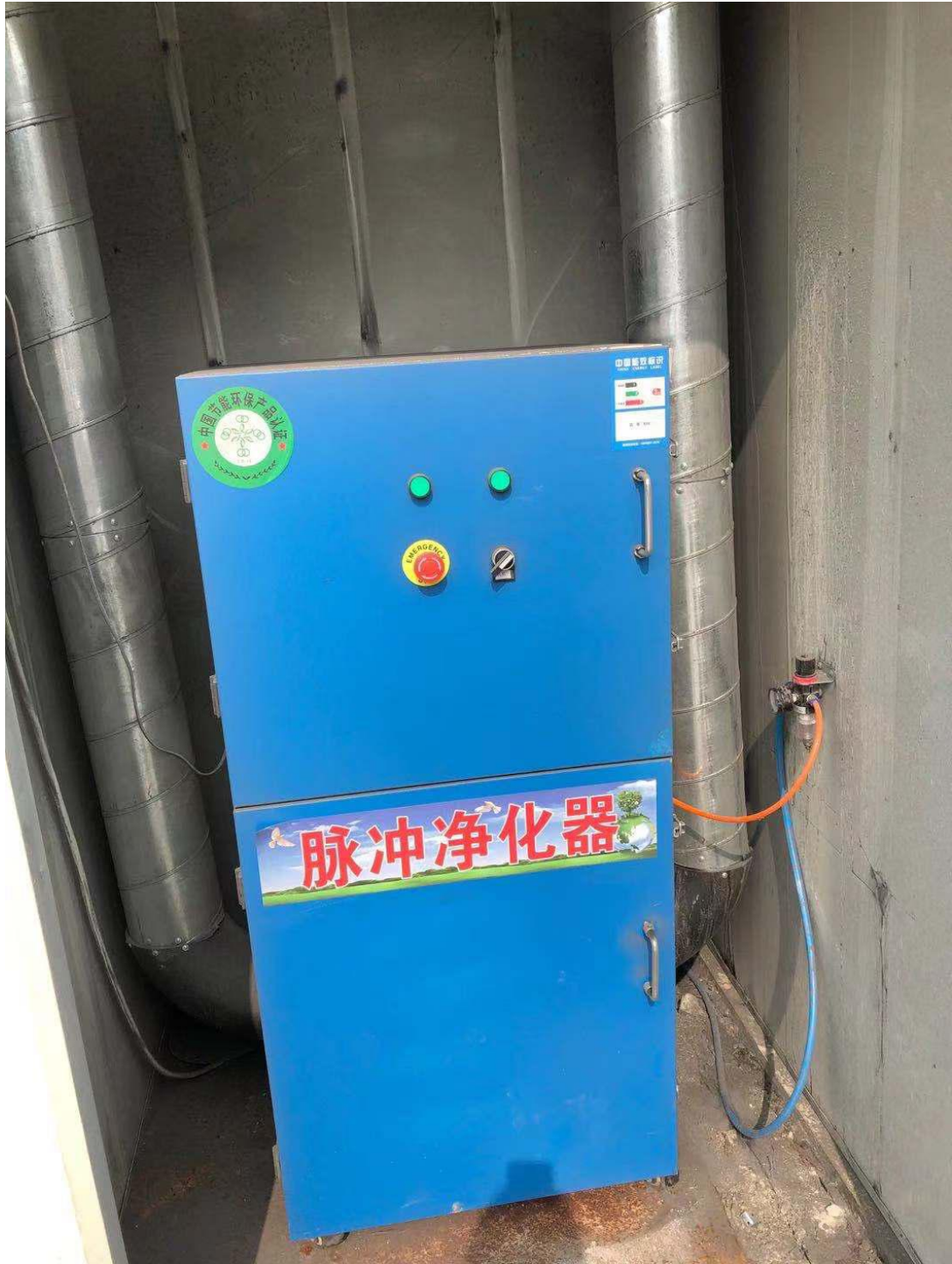
滤筒式脉冲除尘器
