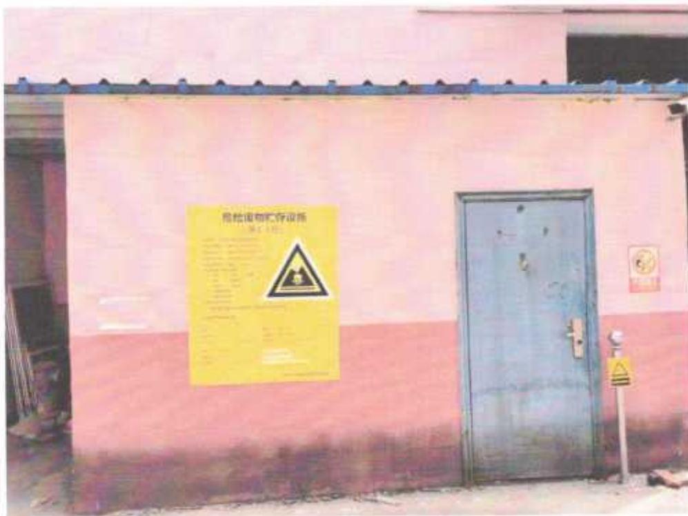
危废仓库现场图
