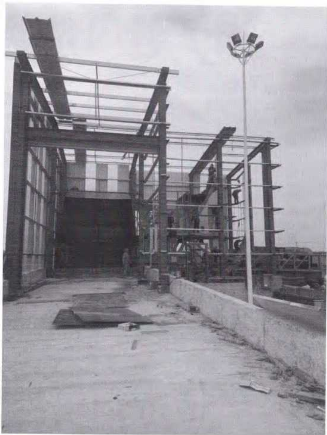
4号泊位施工期现场图
