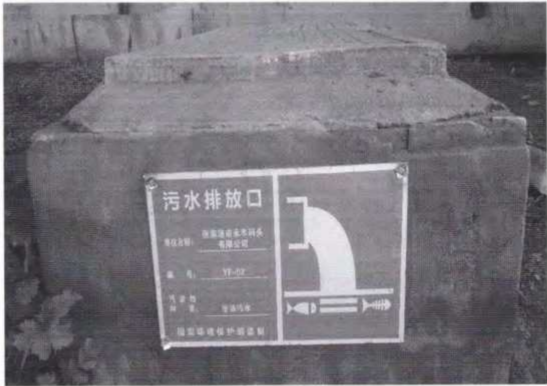
污水排放口标识图
